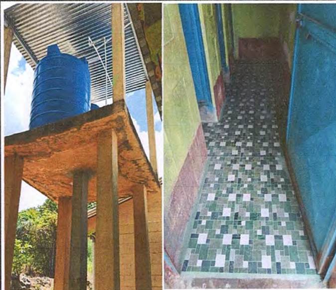
Foto 2: Se finaliza con la instalación de los Depósitos de agua, instalación de tubería para agua potable y colocación de piso en los servicios sanitarios.
